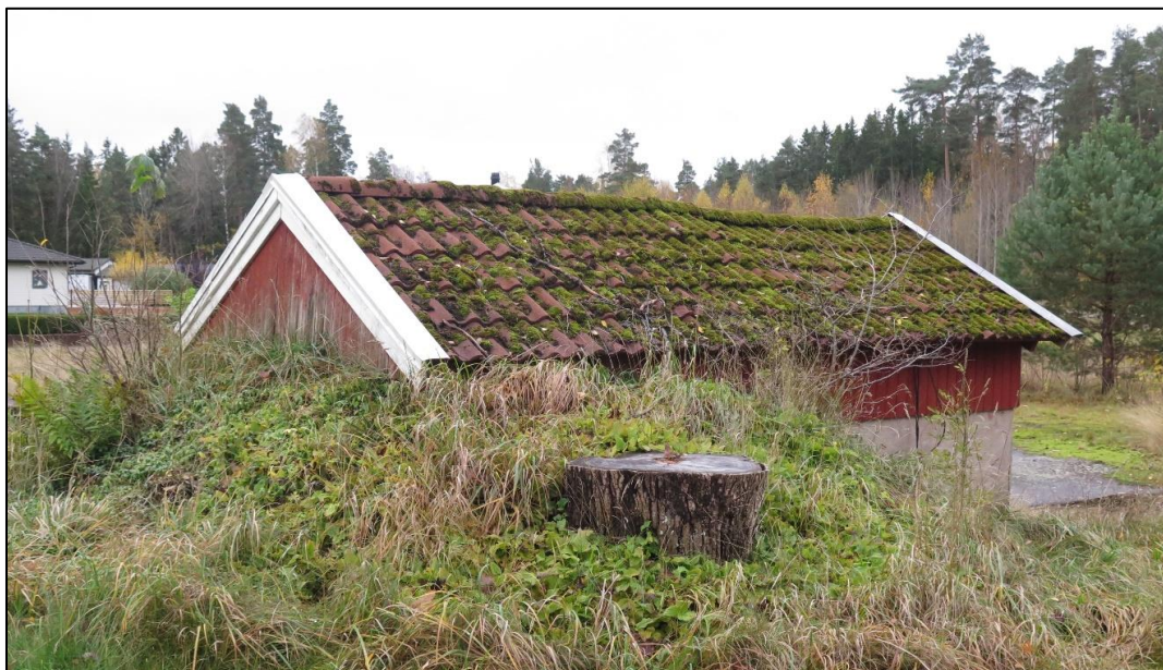
Jordkällaren från norr.
