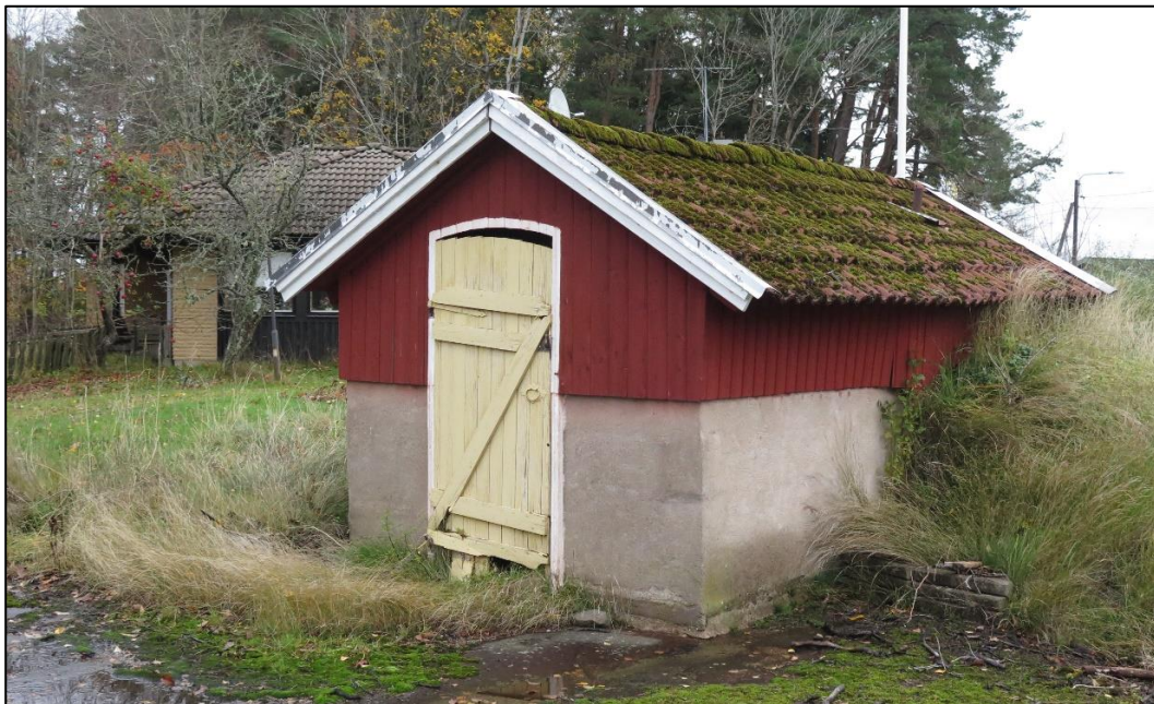
Jordkällaren från söder.
