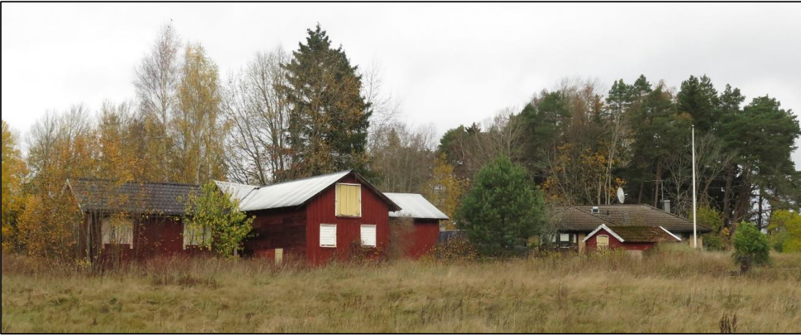
Byggnaderna på Halvorstorp 1:7 från söder. Ladugården närmast i bild, till höger jordkällaren och bakom denna bostadshuset.
