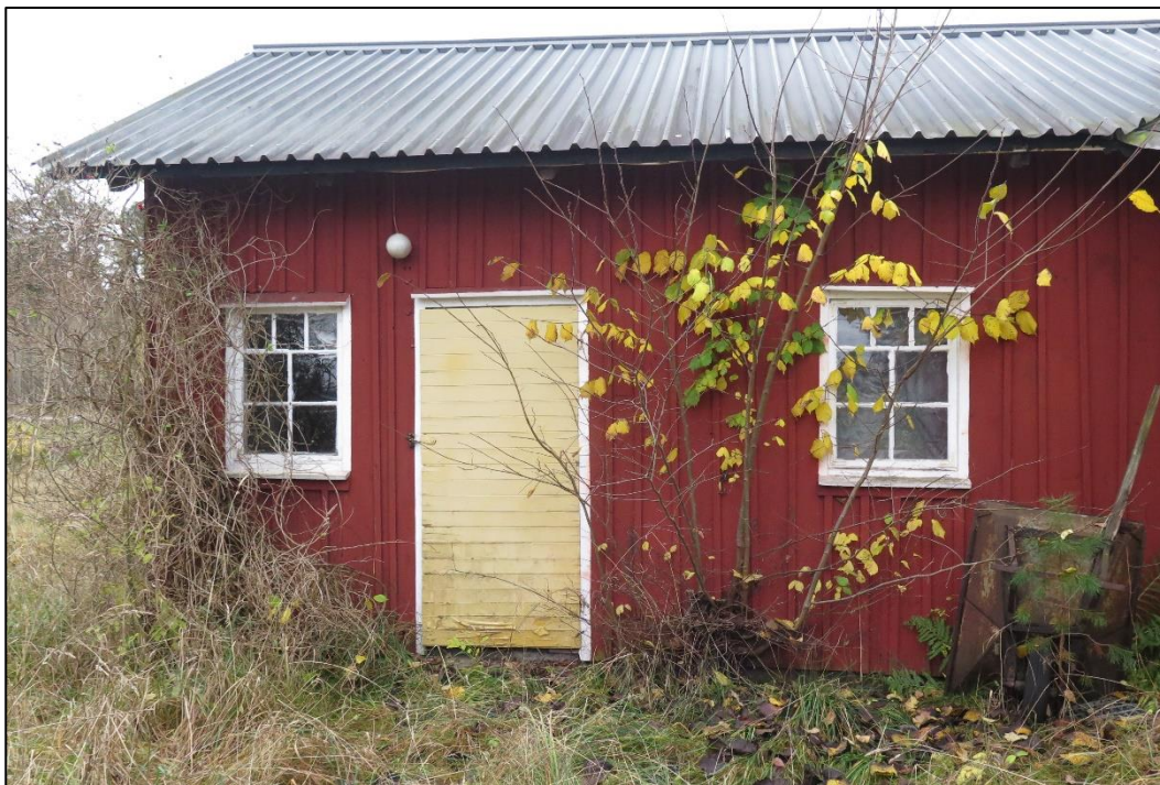
Fähuset med dörr ursprunglig en troligen ursprunglig dörr och karaktäristiska fönster.
